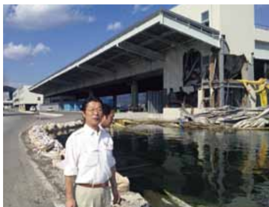
東日本大震災状況調査
