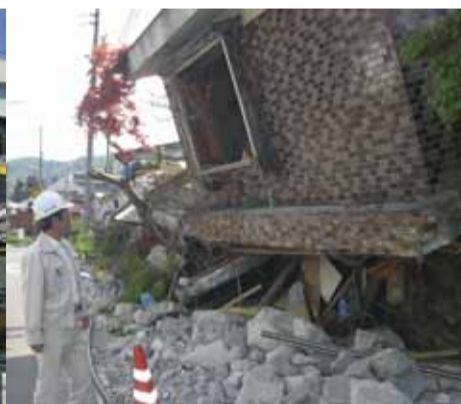
栄村被災状況調査
